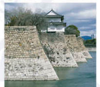
大阪城南外堀の石垣
